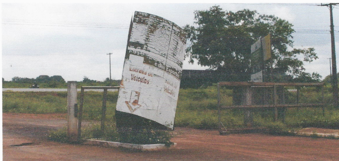
ILUSTRAÇÃO 56 – PLACA DE IDENTIFICAÇÃO DE ENTRADA DO ESTÁDIO
