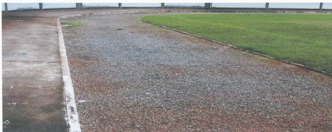
ILUSTRAÇÃO 48 – PISTA DE ATLETISMO EXECUTADA COM BRITA E MEIO-FIO
