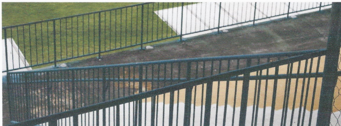
ILUSTRAÇÃO 51 – GUARDA-CORPOS PRESENTES NAS ARQUIBANCADAS DO ESTÁDIO
