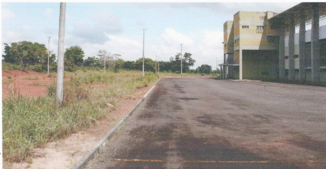
ILUSTRAÇÃO 20 – PAVIMENTO ASFÁLTICO (ESTACIONAMENTO AOS FUNDOS)
