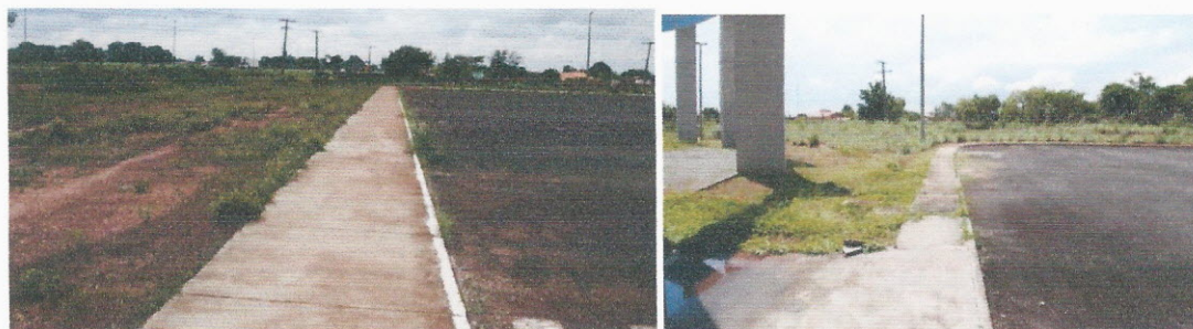
ILUSTRAÇÃO 26 – PASSEIOS DE CONCRETO E MEIO-FIOS
