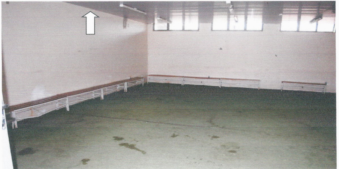
ILUSTRAÇÃO 43 – FORRO DE PVC NA SALA DE AQUECIMENTO DOS VESTIÁRIOS
