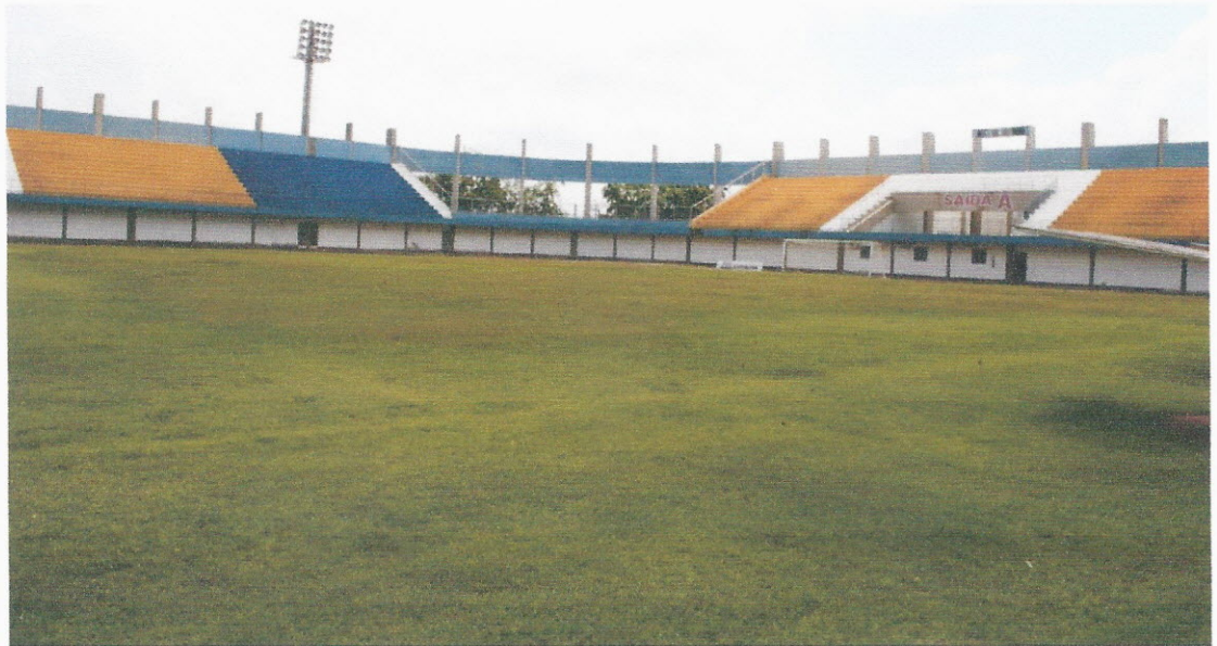
ILUSTRAÇÃO 41 – OUTRA VISTA DAS ARQUIBANCADAS
