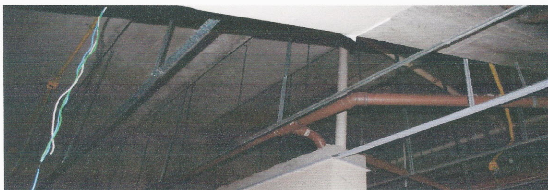
ILUSTRAÇÃO 47 – FORRO RETIRADO NOS SANITÁRIOS DA TORCIDA (REFORMA)
