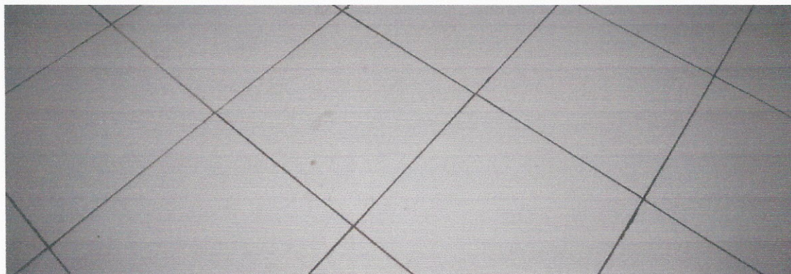
ILUSTRAÇÃO 38 – PISO CERÂMICO EXECUTADO
