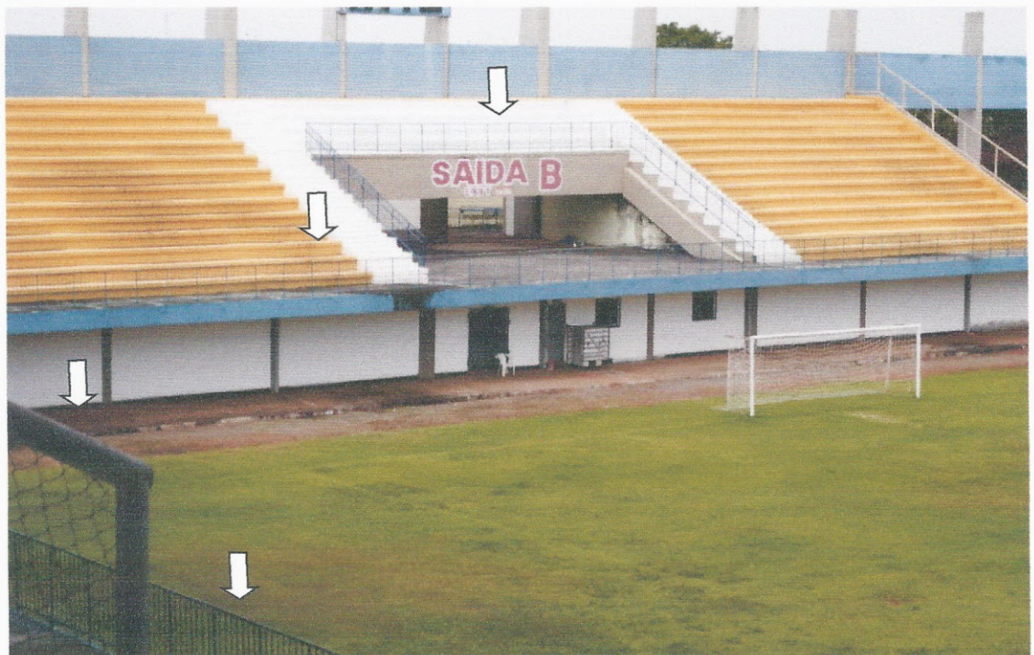
ILUSTRAÇÃO 42 – ELEMENTOS TUBULARES METÁLICOS DOS GUARDA-CORPOS
