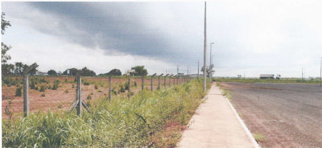
ILUSTRAÇÃO 29 – ALAMBRADO LATERAL, MEIO-FIO E CALÇADA
